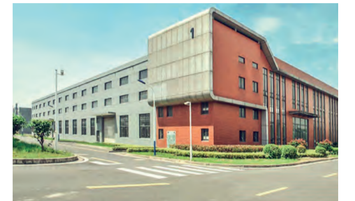
Der moderne MAPLAN Standort im Industriepark von Wujin bietet alle Möglichkeiten für den erfolgreichen Start in China.
