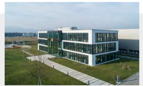
ERÖFFNUNG NEUES HQ KOTTINGBRUNN
