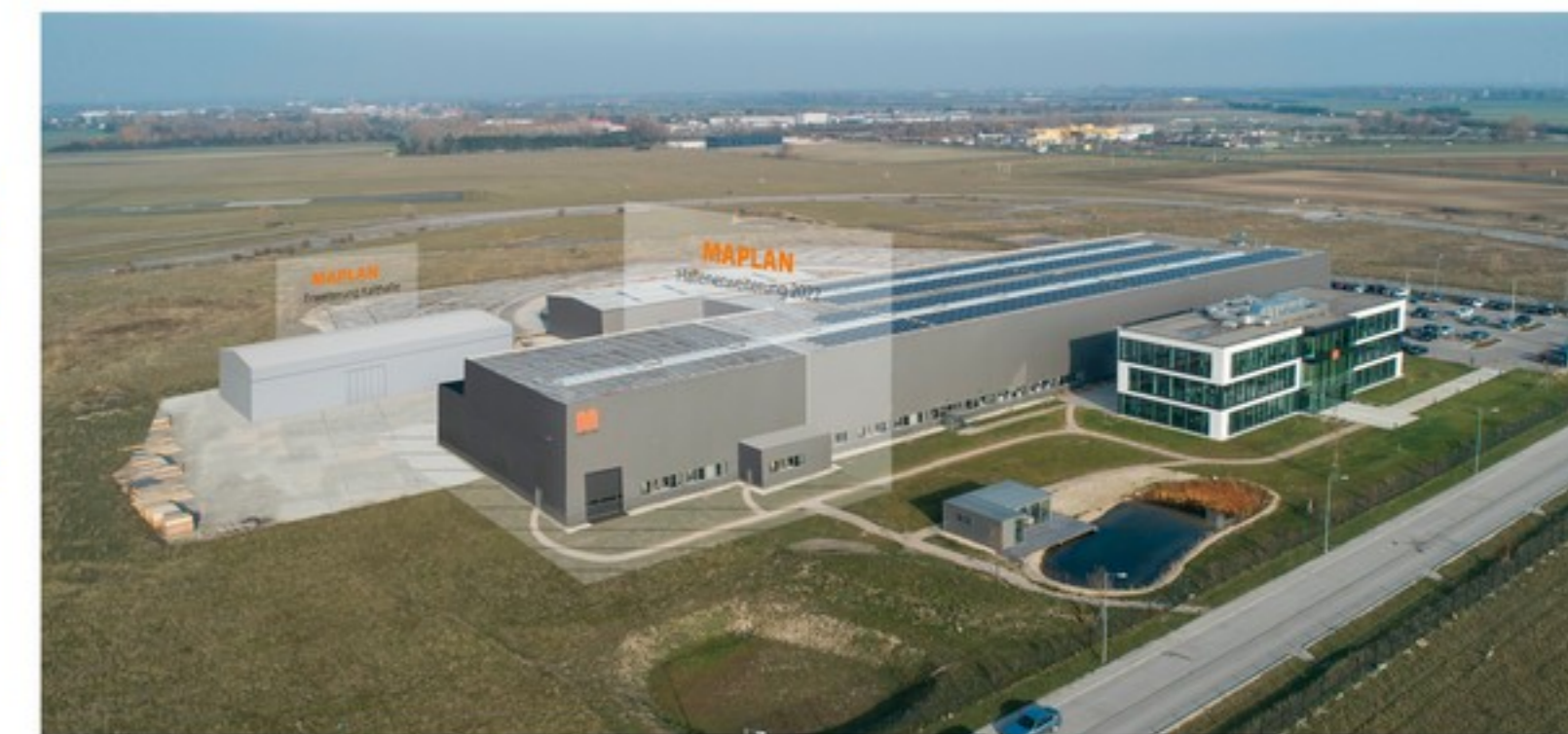
Die Produktionsfläche des MAPLAN Headquarters in Kottlingbrunn wird um 40 % erweitert - die Lagerkapazitäten um eine Kalthalle vergrößert.
